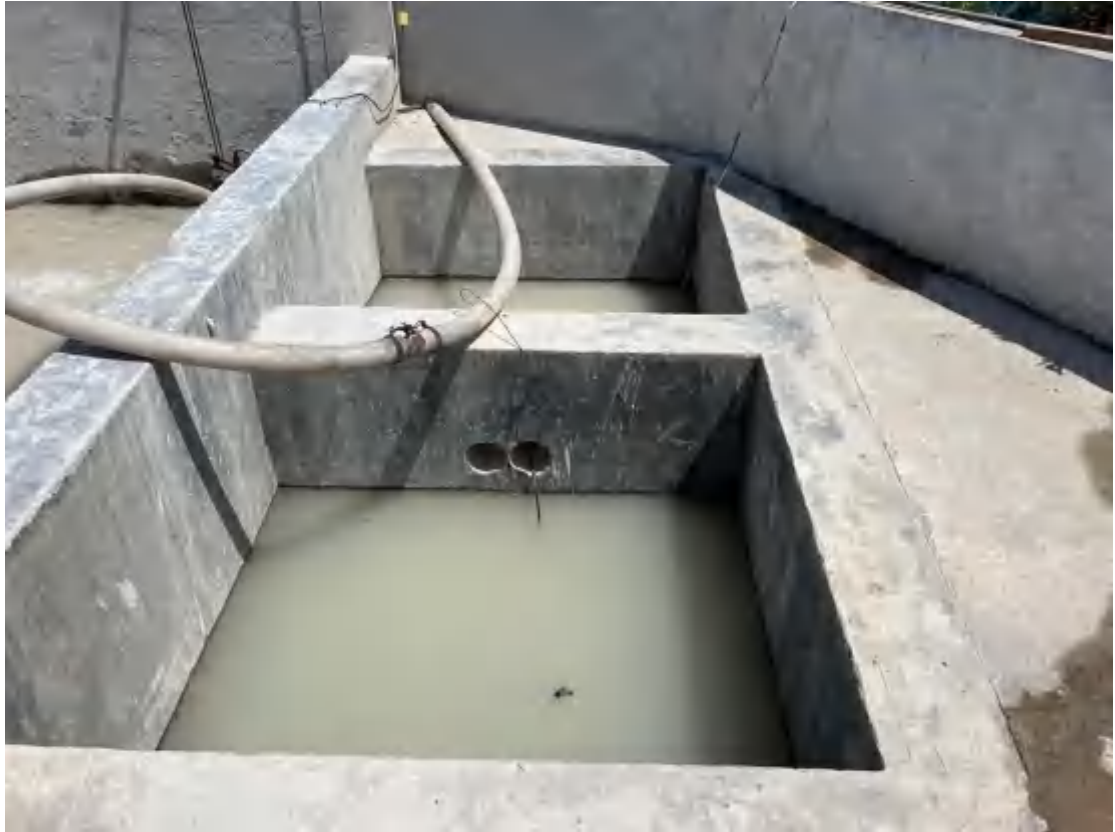
厂外道路区沉沙池
