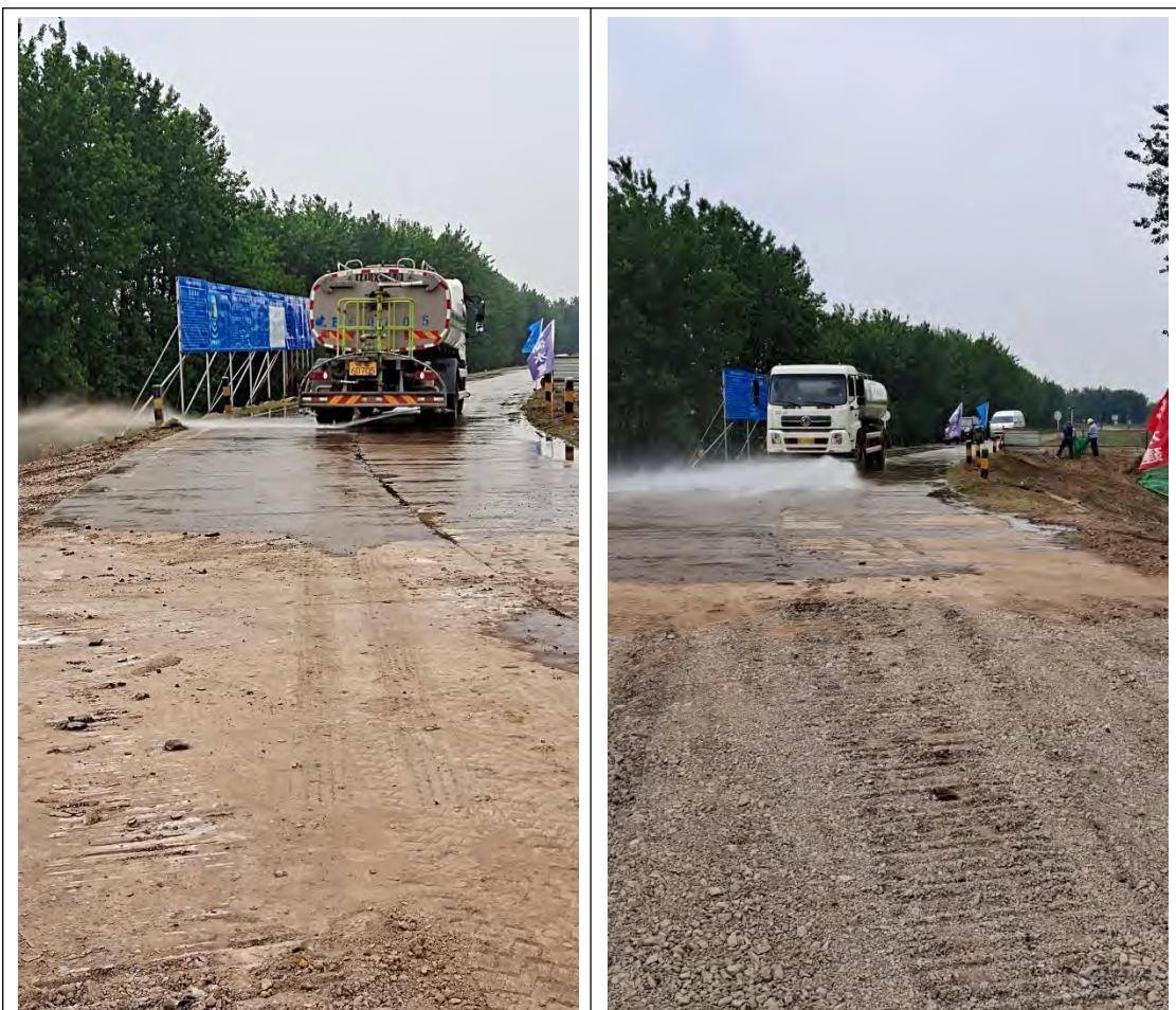
施工现场洒水抑尘
