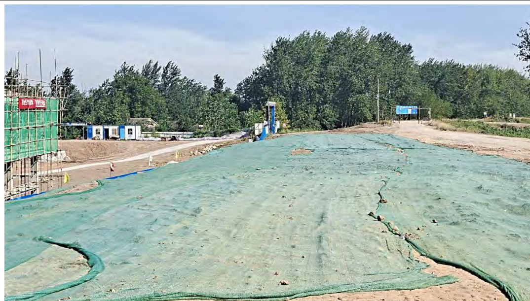
施工现场铺设绿网抑尘
