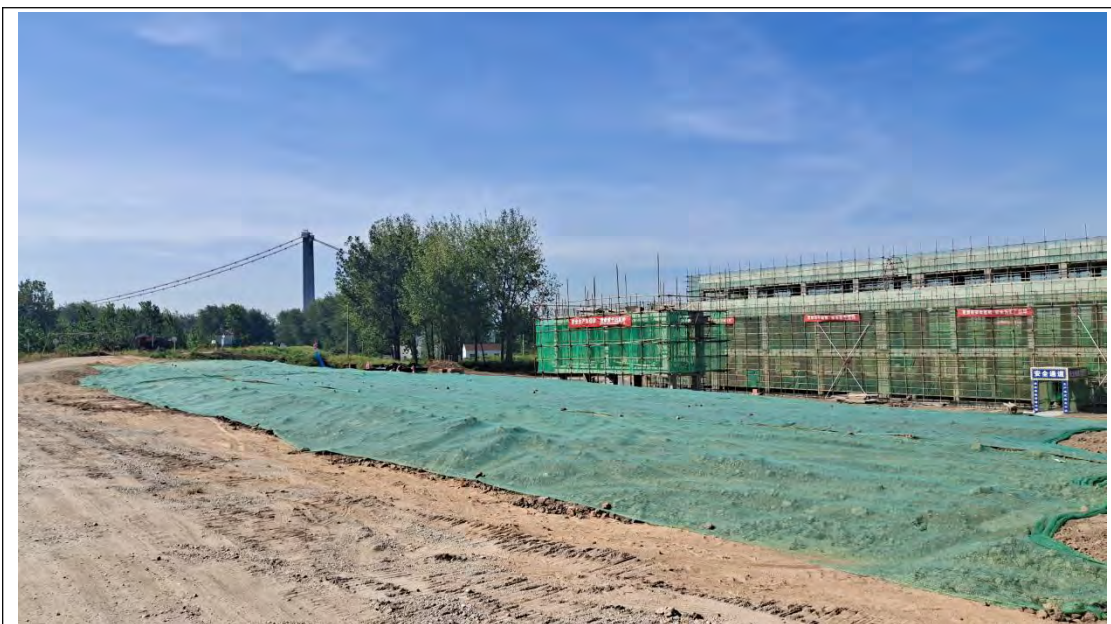
施工现场铺设绿网抑尘
