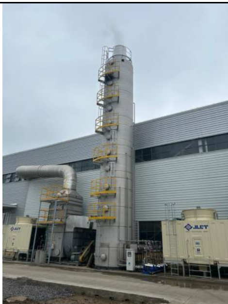
1#PU 革生产线五级水喷淋塔及废气排放口（DA001）设置情况
