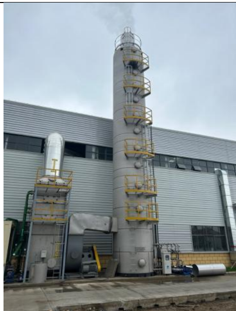
2#PU 革生产线五级水喷淋塔及废气排放口（DA002）
