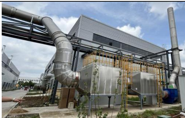
PU 革生产线表面处理、后处理活性炭吸附装置及排放口（DA003）
